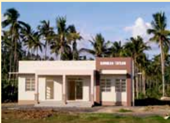
草の根技術協力事業で建設されたばかりの公民館(フィリピン・レガスピ市タイサン村)
